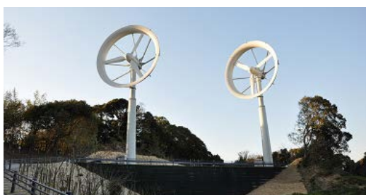
70kW×2 風レンズ型風力発電設備
